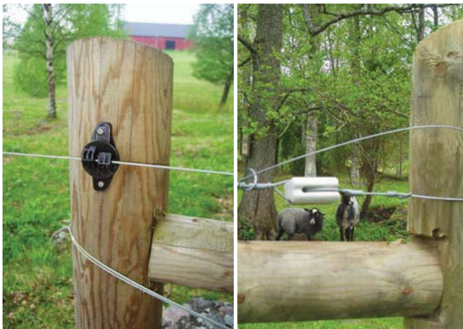
Hållbara isolatorer skruvas med gipsskruv.
